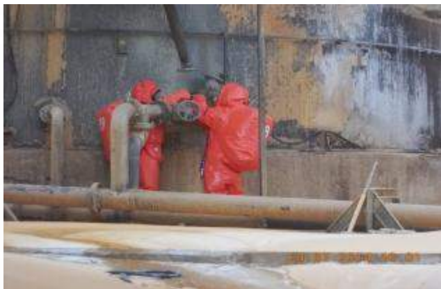
Fuite bac de stockage de soude, Gardanne, 25 juillet 2014
