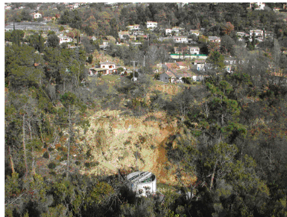
Vue générale du glissement Pra de Julian - Vence
