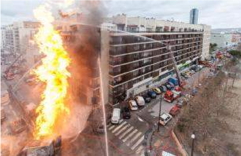
Fuite de gaz enflammée, Marseille, 7 janvier 2014
