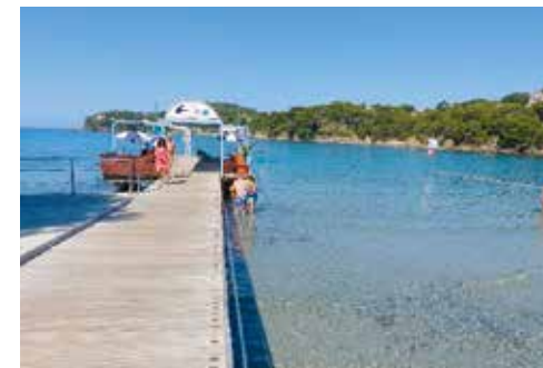
Illustration d'une barre d'appui installée sur toute la longueur du ponton
