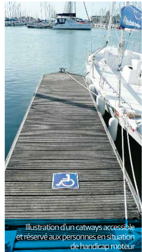
Illustration d'un large ponton avec bordure chasse-roue
