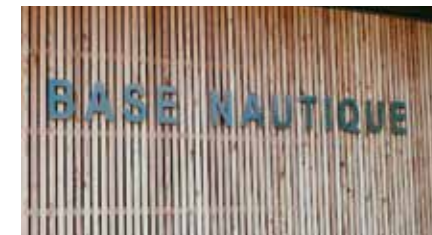
Exemple de signifiant visuel sur la façade d'une base nautique inscrit en gros caractères mais avec un contraste insuffisant
