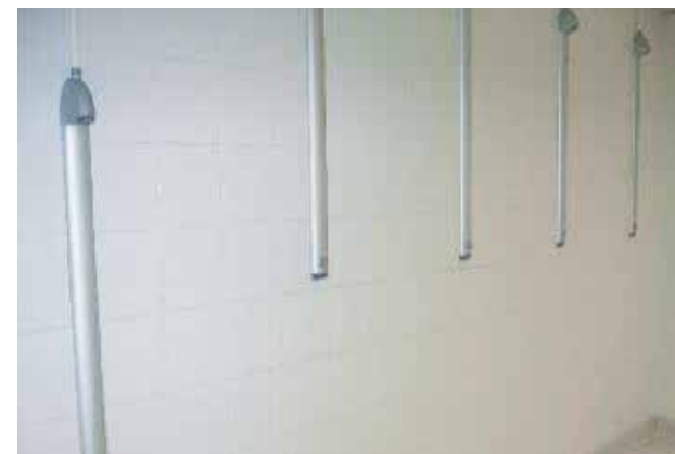
Exemple de commandes de douches faciles à manoeuvrer et situées à différentes hauteurs
