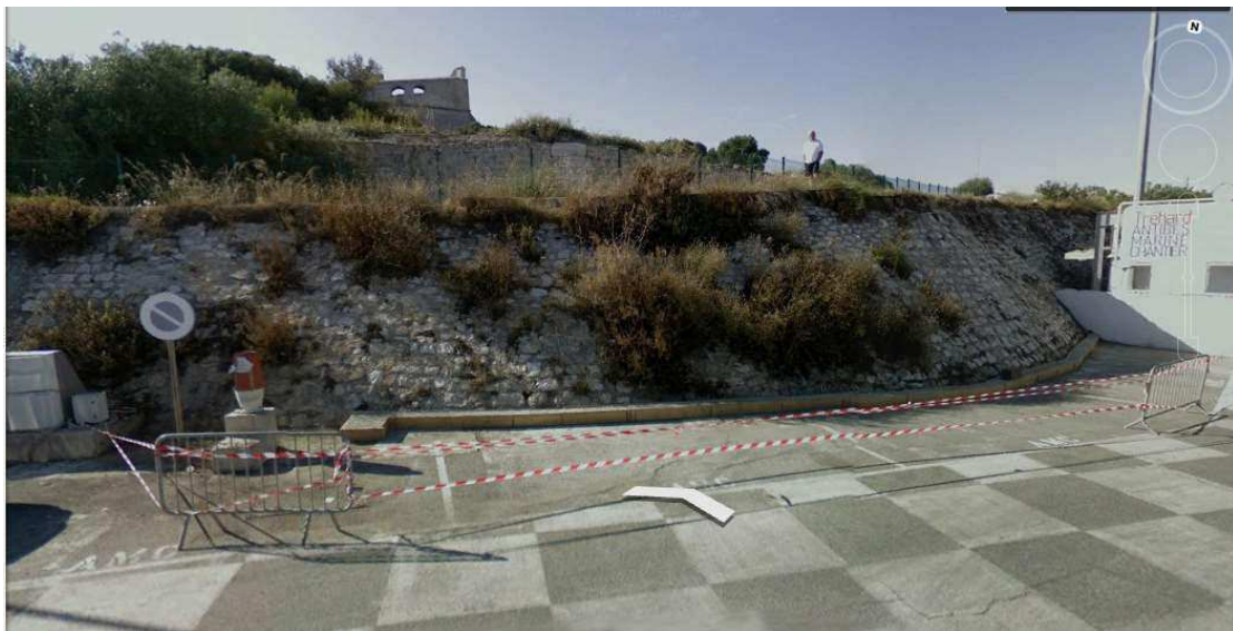
Figure 35: Mur de contre escarpe
