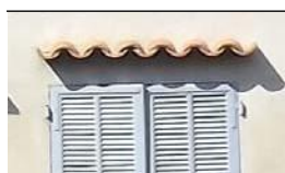
Rangs de tuiles au-dessus des linteaux proscrits
