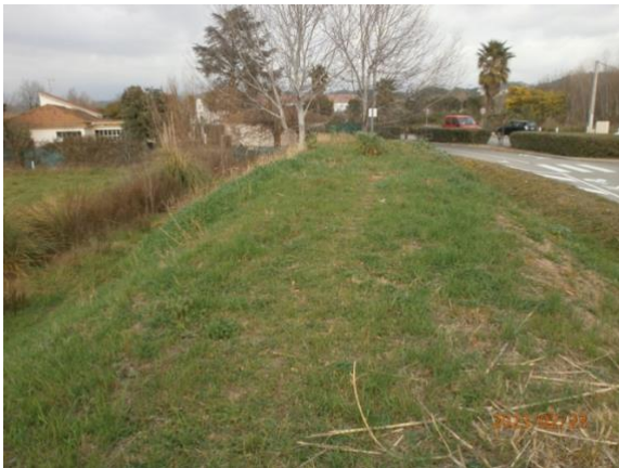
Extrémité Digue Nord St-Exupéry
