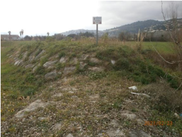
Digue St-Exupéry – Sud vers A.8
