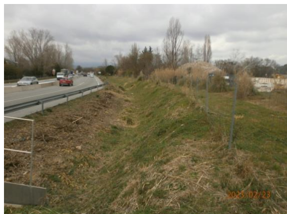
Digue Échangeur Nord/ Vers PEGOMAS
