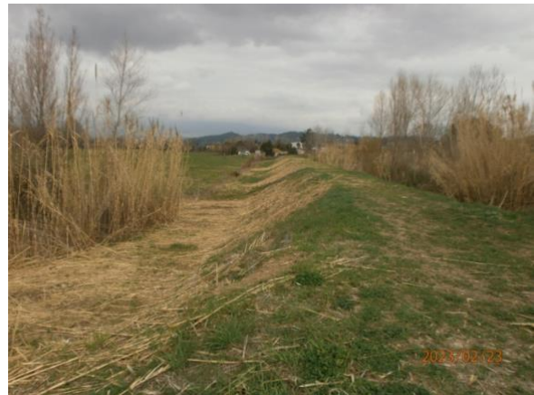
Digue St-Exupéry – Nord vers D 1009
