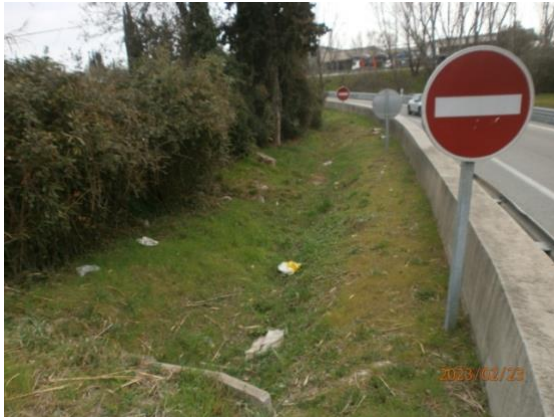
Digue sortie Bretelle A8
