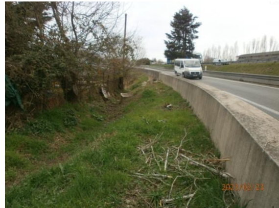
Digue sortie Bretelle A8
